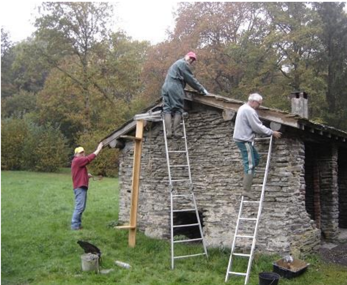
Pendant les travaux : les poutres en chêne sont hissées.
